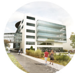
VOJENSKÁ NEMOCNICE BRNO PAVILON OPERAČNÍCH OBŮRŮ
